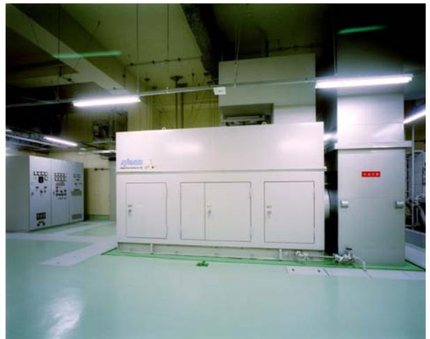
写真：自家発電設備(ガスタービン発電機)
